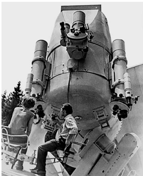
Спутниковые камеры ВАУ (слева) и "АФУ-75" (справа)
